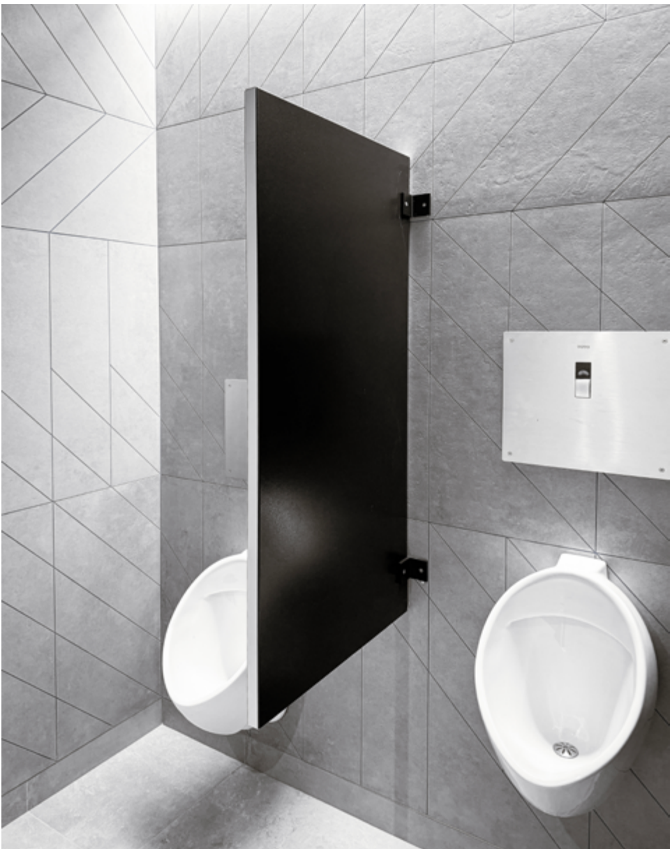
Urinaltrennwände aus 30 mm starken Verbundelementen aus Aluminium in der Farbe Strong Black 7022
