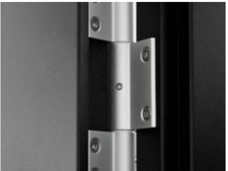
Drei-Rollen-Kantenbänder , sechsfach verschraubt
